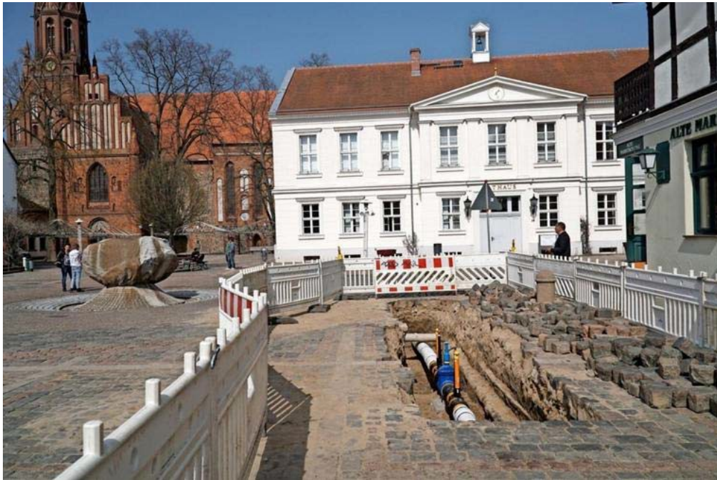
Auf dem Pritzwalker Marktplatz werden Teile der Gasleitung erneuert. Quelle: Andreas König
