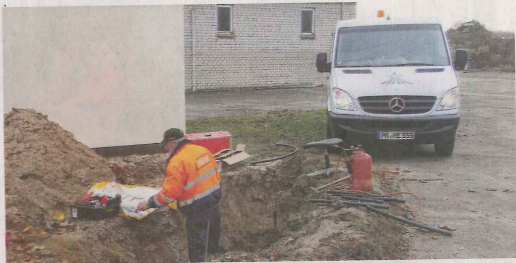
Die Elektriker für Energie- und Gebäudetechnik beim Verlegen von Kabeln. FOTOS: THOMAS BEIN
